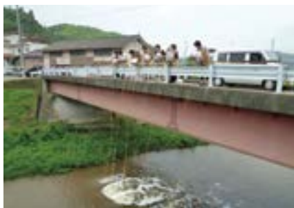
つきだてエコ暮案部 河川浄化・プール清掃のほか、公共施設への活性液配布など地区内で幅広く活動している。
