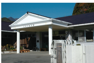
障がい者支援施設 しくなげ荘 (高知県長岡郡本山町)
