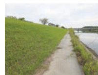
▲石崎川の堰堤
