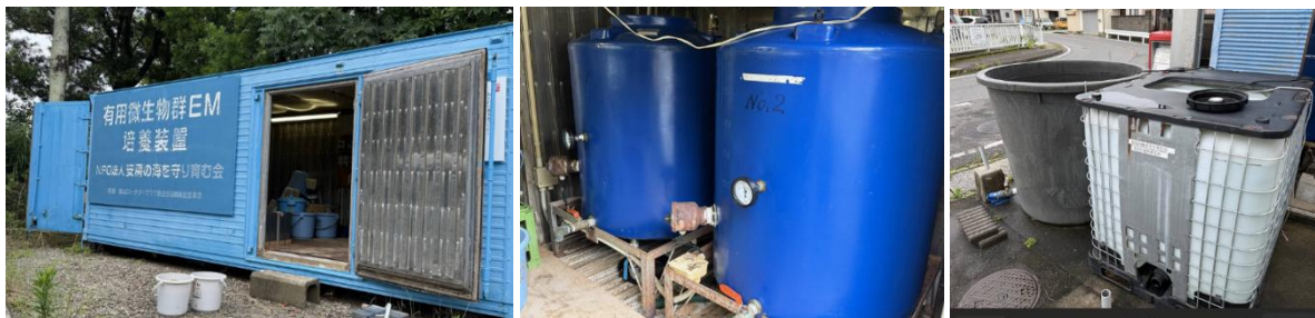
写真:左からEM培養倉庫と電熱付き培養タンク、1tタンク
