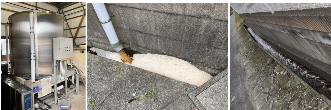
写真:第3倉庫の3tの電熱付き培養タンク(左)、側溝へのEM活性液放流の様子(中央、右)
